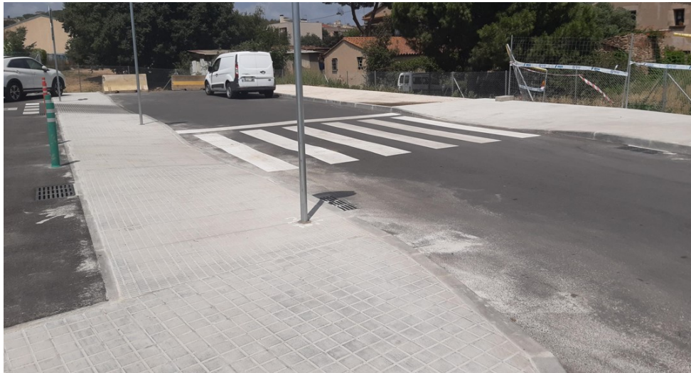
Imatge 2. Tram de c/Fabrica recentment executat
